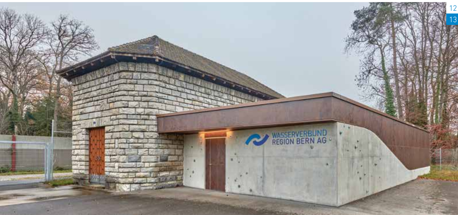
11 – Anbau an den bestehenden Endfallheber in Kiesen für das neue Hebersystem Oberi Au und Amerikaegge.
