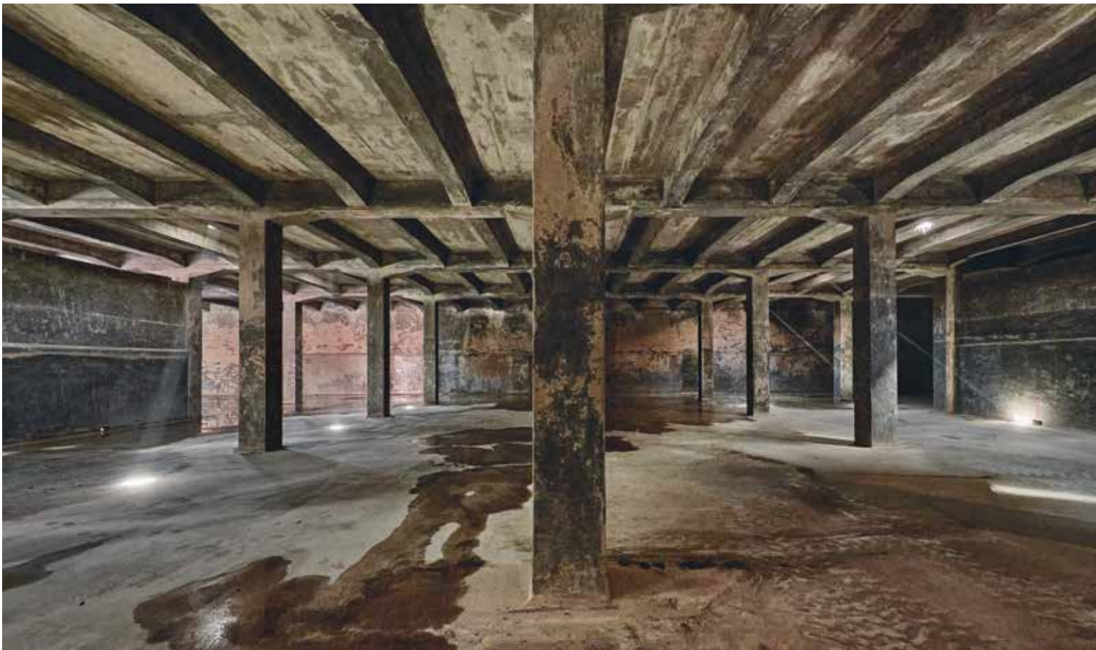
06 – Die dritte Erweiterung mit den Kammern 2 und 3 des Reservoirs Mannenberg 1913.
