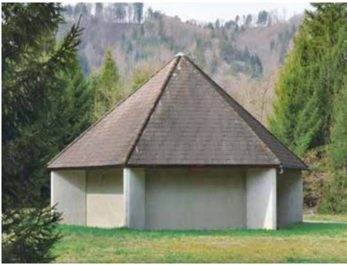
10 – Horizontalfilterbrunnen in der Belpau.
