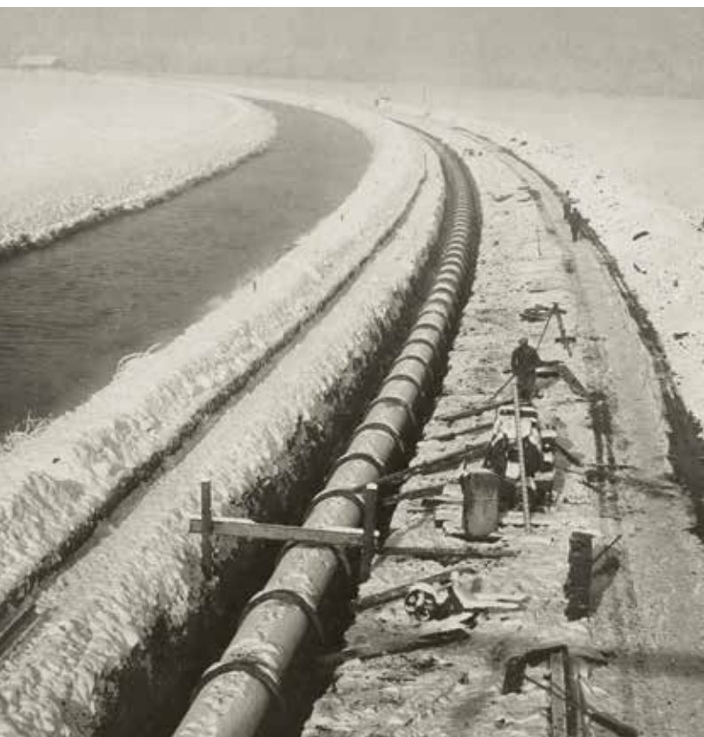
07 – Freispiegelleitung entlang der Gürbe in Belp.
