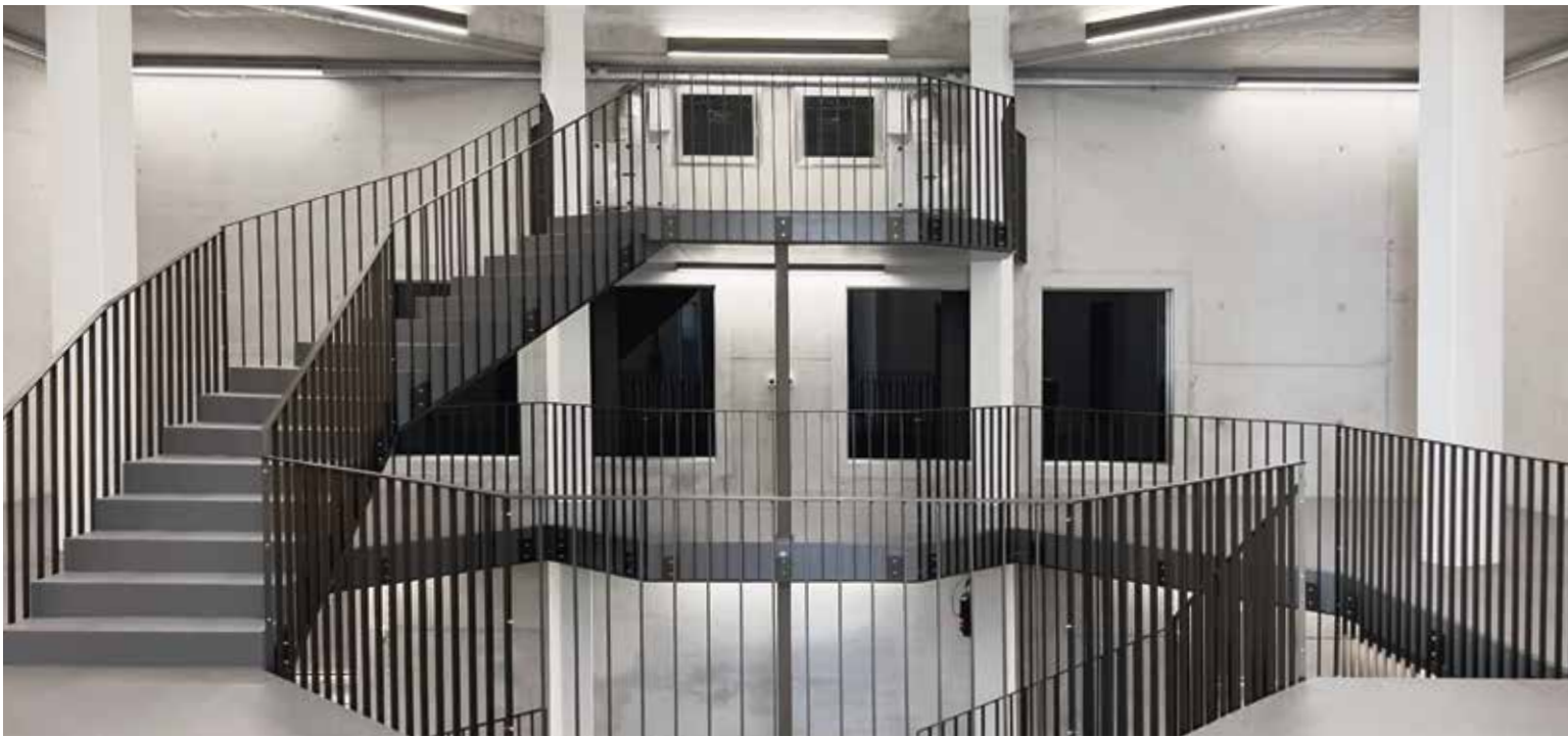
13 – Das Treppenhaus in der Wehrliau.
