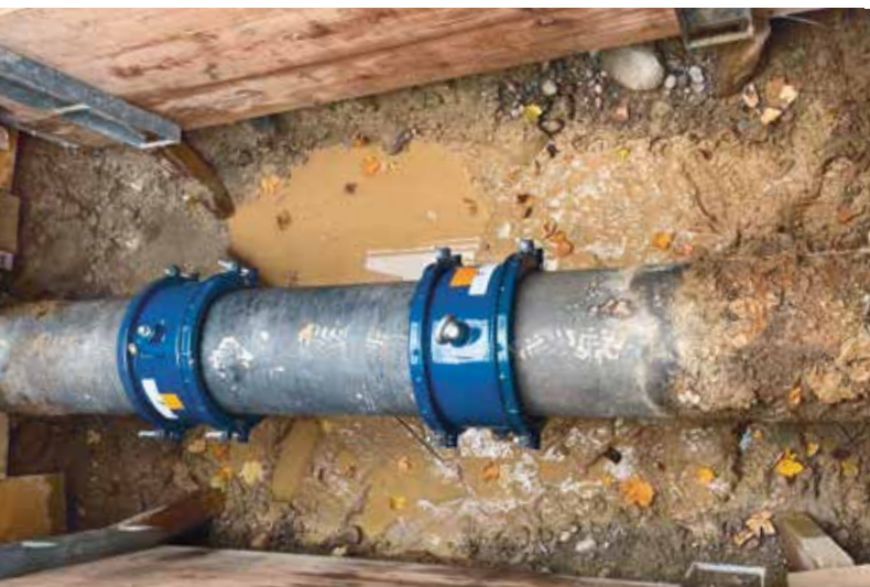
38 – Fachgerecht reparierte Leckstelle einer Trinkwasserleitung. Geborstene Leitungen verursachen sehr hohe Kosten.
