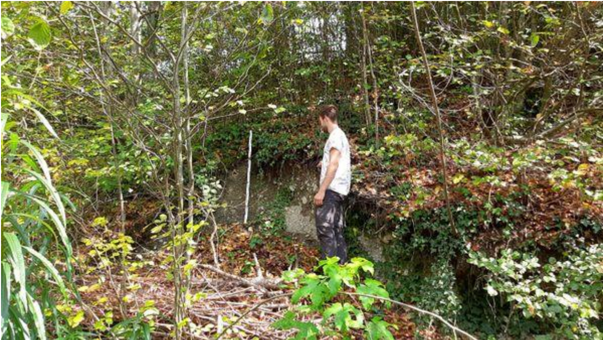
Abbildung 6: Bestehende Anrisszone (Hangneigung: ca. 50°).
